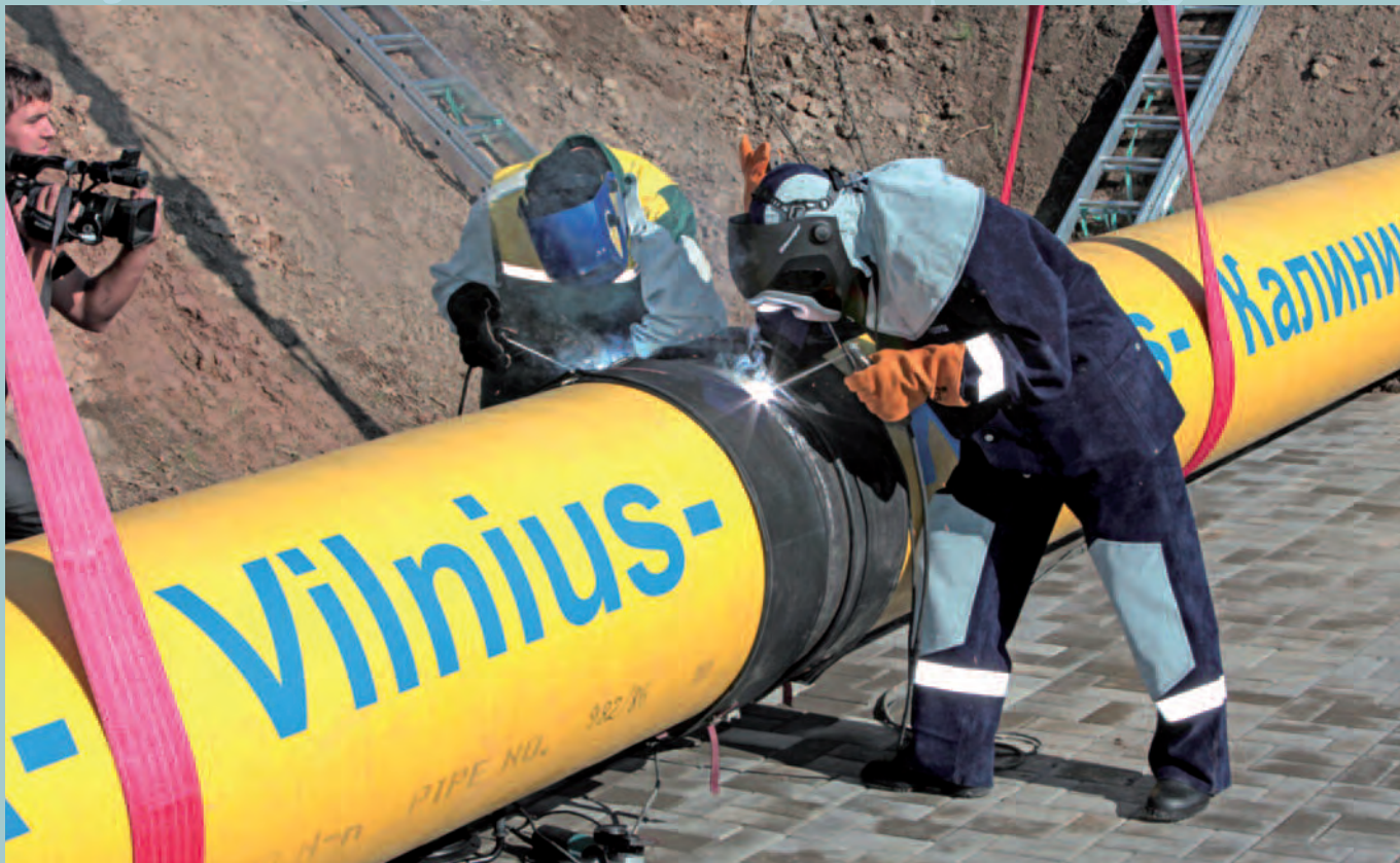
Soudure de la première jointure sur le pipeline Minsk-Vilnius-Kaunas-Kaliningrad.
