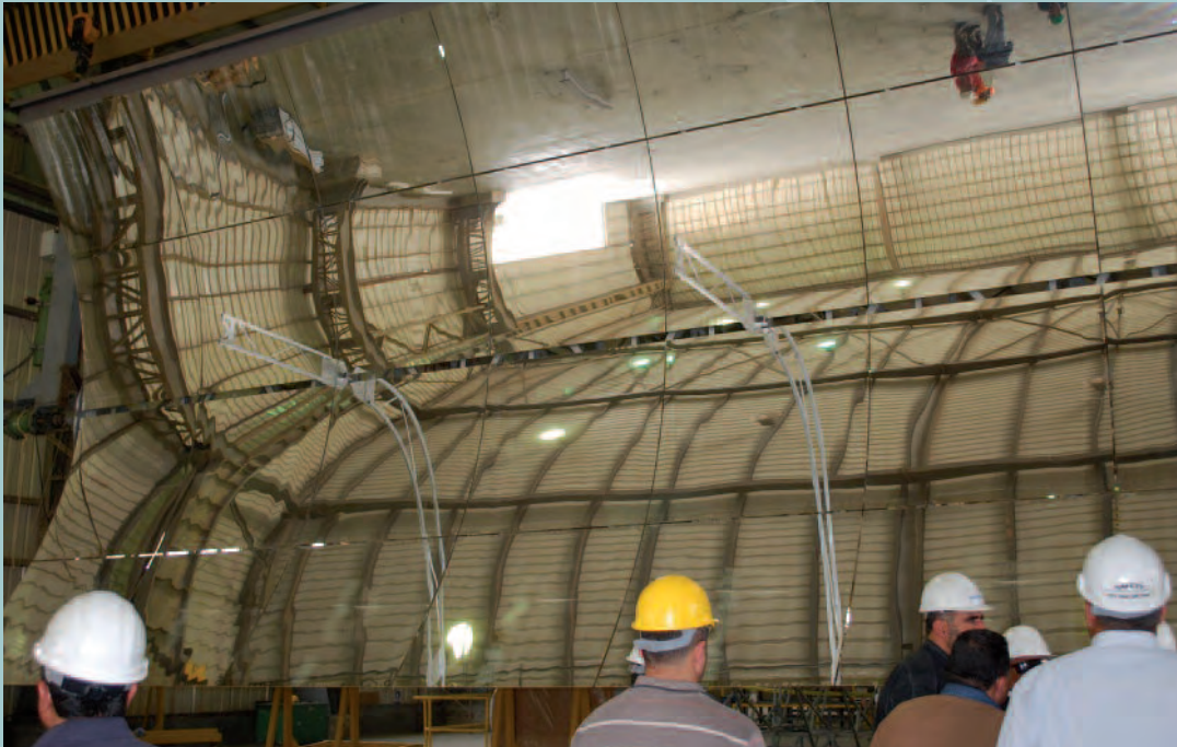
La construction de la centrale solaire d'El Kureimat, à 90 kilomètres au Sud du Caire, a reçu un financement de la Banque mondiale, sous forme d'un don de 46,9 millions de dollars en 2007.
